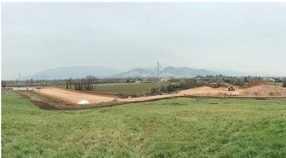
A Ciliverghe. Prosegue la bonifica dell'ex discarica della frazione
